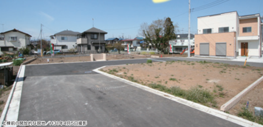
上棟前の開放的な現地/H31年4月5日撮影
